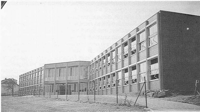
Der Erweiterungsbau der Carl-Benz-Schule, von Nordwesten gesehen, mit seiner großzügigen Fensterfront. Foto: W. Rabold
